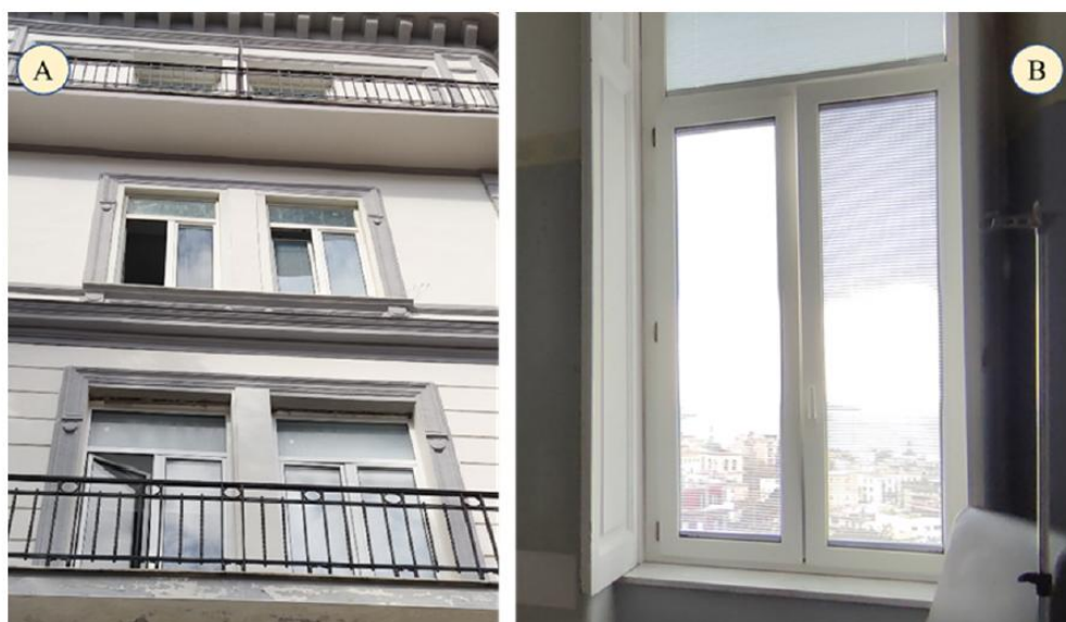
Figura 43. Finestre: (A) lato esterno—sud; (B) lato interno
