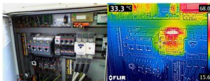
Figura 46 Immagini fotografiche e IR del pannello MHCS
