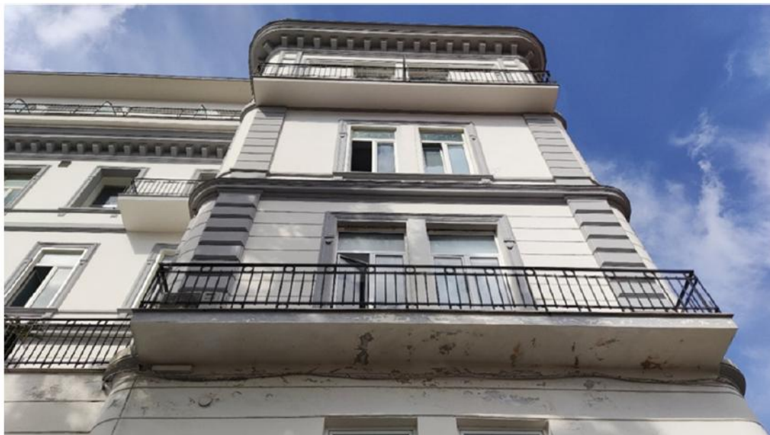
Figura 41. Involucro dell'edificio: facciata sud
