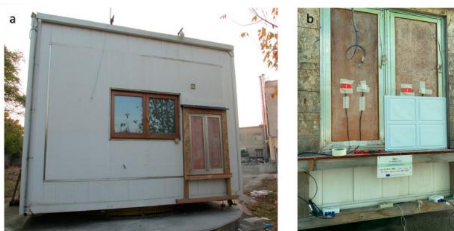
Figura 18. (a) Installazione completa di GI (novembre 2019); (b) lavoro per l'applicazione PCM (maggio 2021)
