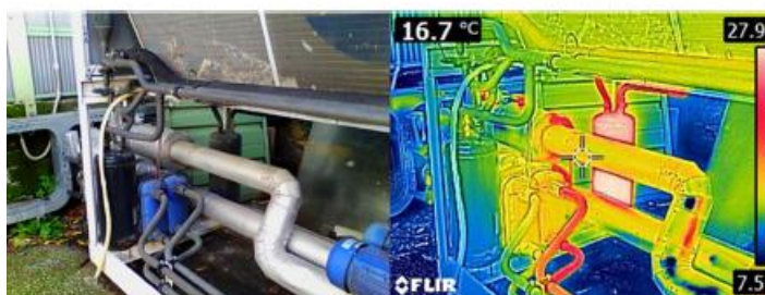
Figura 45. Immagini fotografiche e IR dell'MHCS
