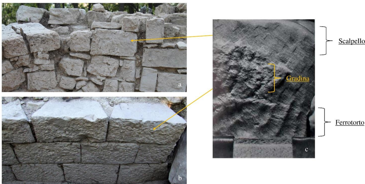
Fig. 344. Segni di strumenti: a) Scalpello, usm 1725; b) Gradina, usm 2000; c) Blocco in marmo (ROCKWELL 1989, fig. 10).
