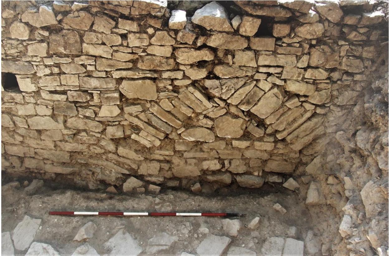
Fig. 155. Settore esterno ovest della chiesa, arco di scarico del muro 1833.
