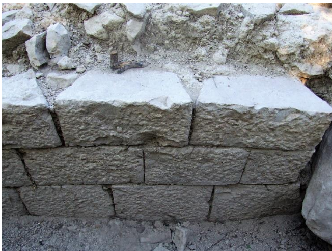
Fig. 169. Dettaglio del paramento di usm 2000 con blocchetti ammassati nel nucleo.
