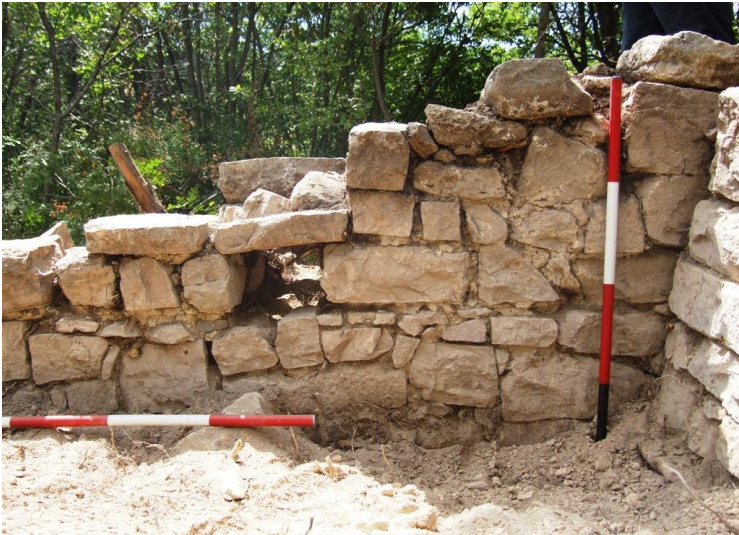
Fig. 166. Foro pontale 1511 sul perimetrale este della navata sinistra (durante lo scavo dell'area esterna a sud del campanile – 2013).
