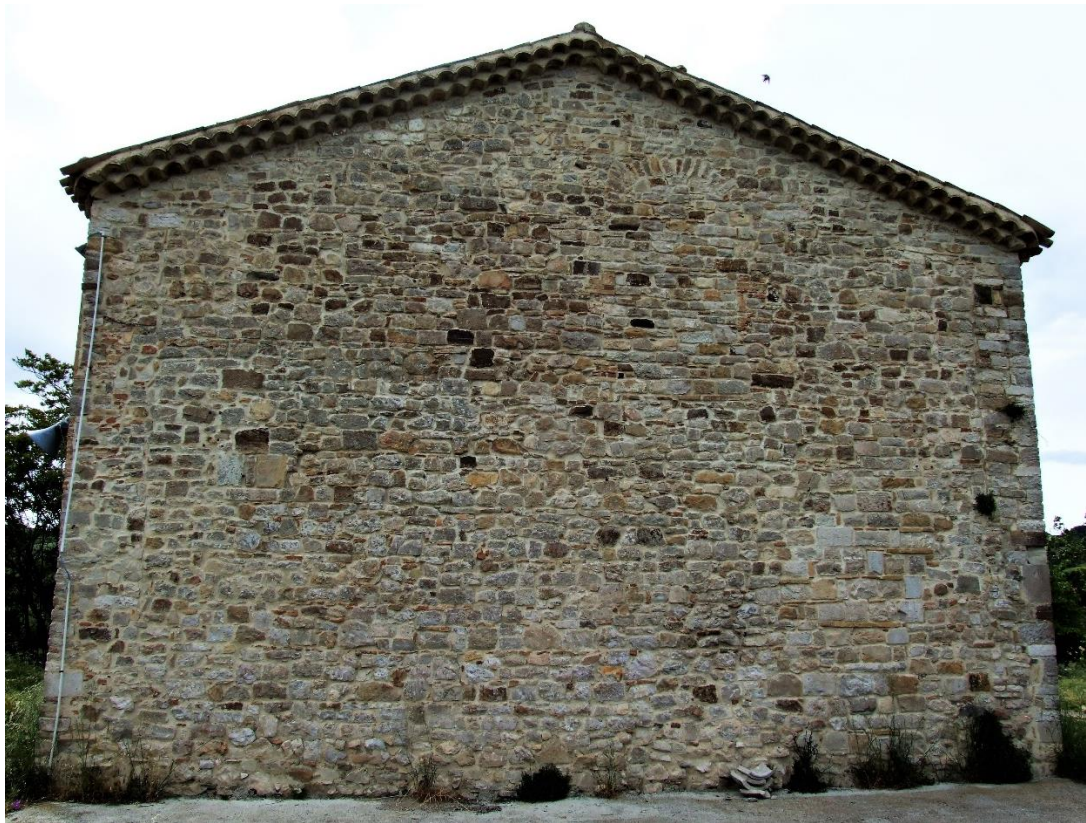
Fig. 28. Prospetto posteriore della chiesa di San Pietro a Sant'Elia a Pianisi (foto. C. Ebanista).
