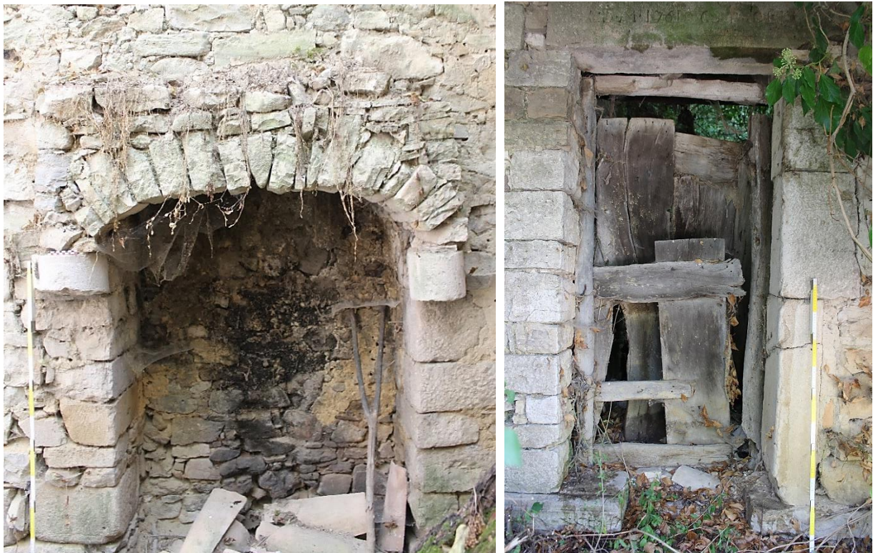
Fig. 329. Casolare, camino con frammenti di colonnine e porta con epigrafi, conci e mensole riutilizzati (foto C. Ebanista).
