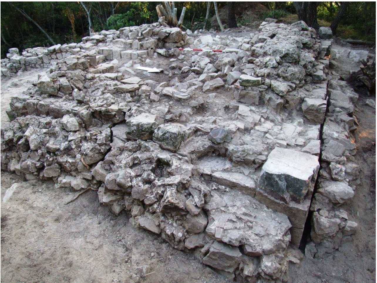
Fig. 161. Campanile, cortina muraria durante la campagna di scavo 2013.
