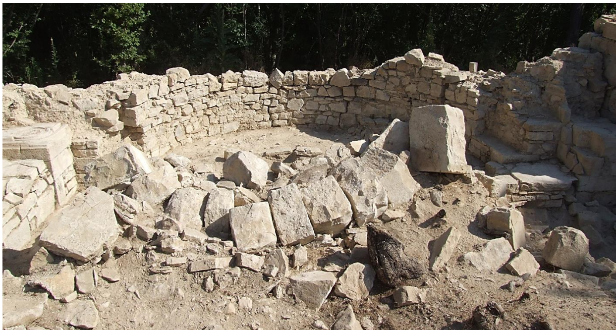
Fig. 112. Navata centrale, zona absidale. Crollo dell'arco trionfale (us 1897) prima dell'asportazione.
