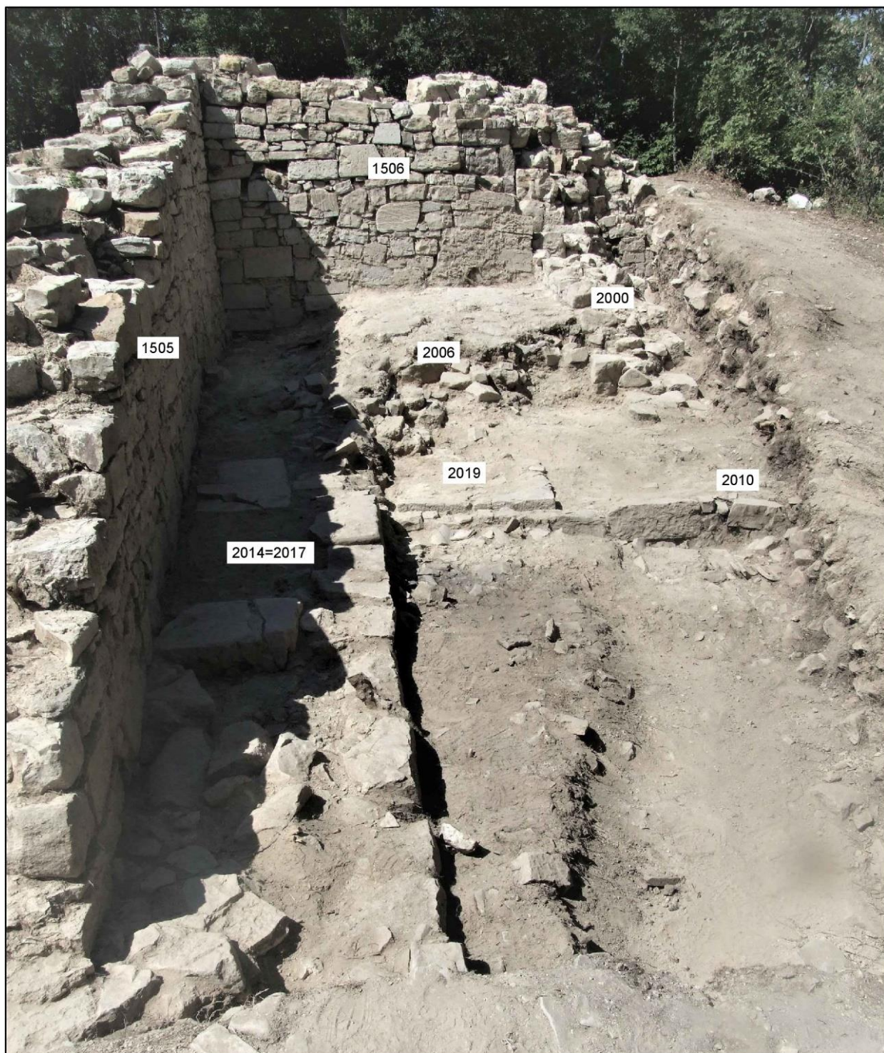
Fig. 349. Pianisi, area esterna a sud del campanile. A sinistra il perimetrale 1505 impiantato al di sopra di 2014=2017.
