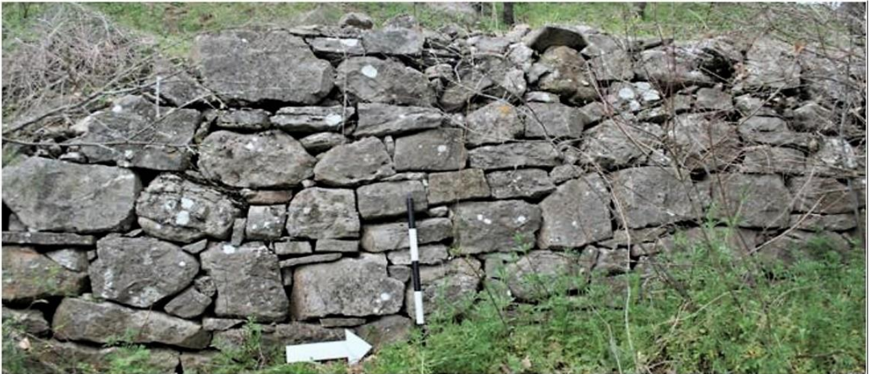
Fig. 34. Contrada San Benedetto, struttura muraria sul versante sud-est (COLAVITA 2015-16, p. 25, fig. 11).
