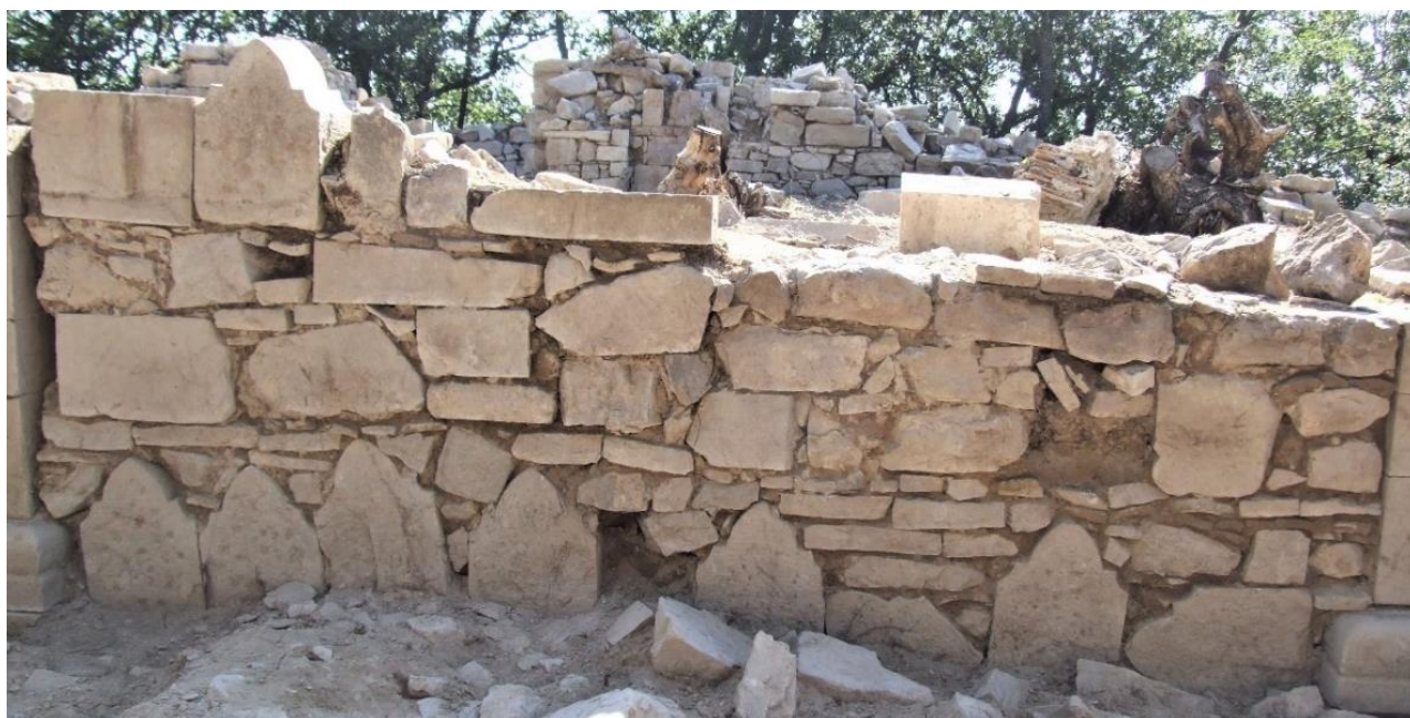
Fig. 130. Navata sinistra, tamponatura 1825 con alcuni elementi lapidei ogivali di reimpiego.
