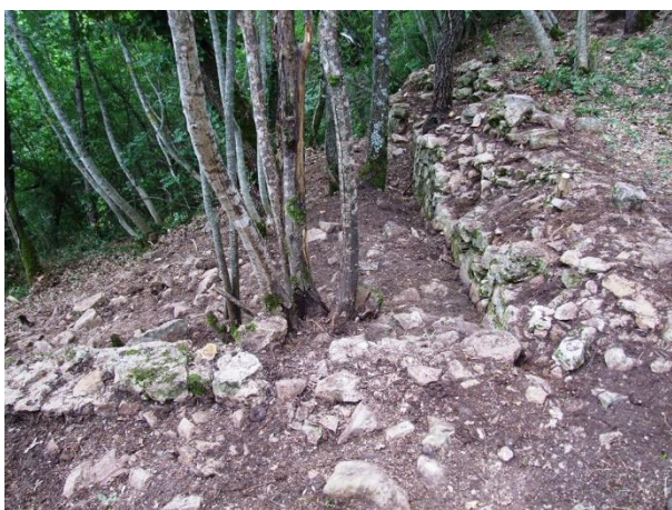
Fig. 94. Muro di sostruzione del terrazzamento superiore, versante orientale (usm 1003 e 1004).
