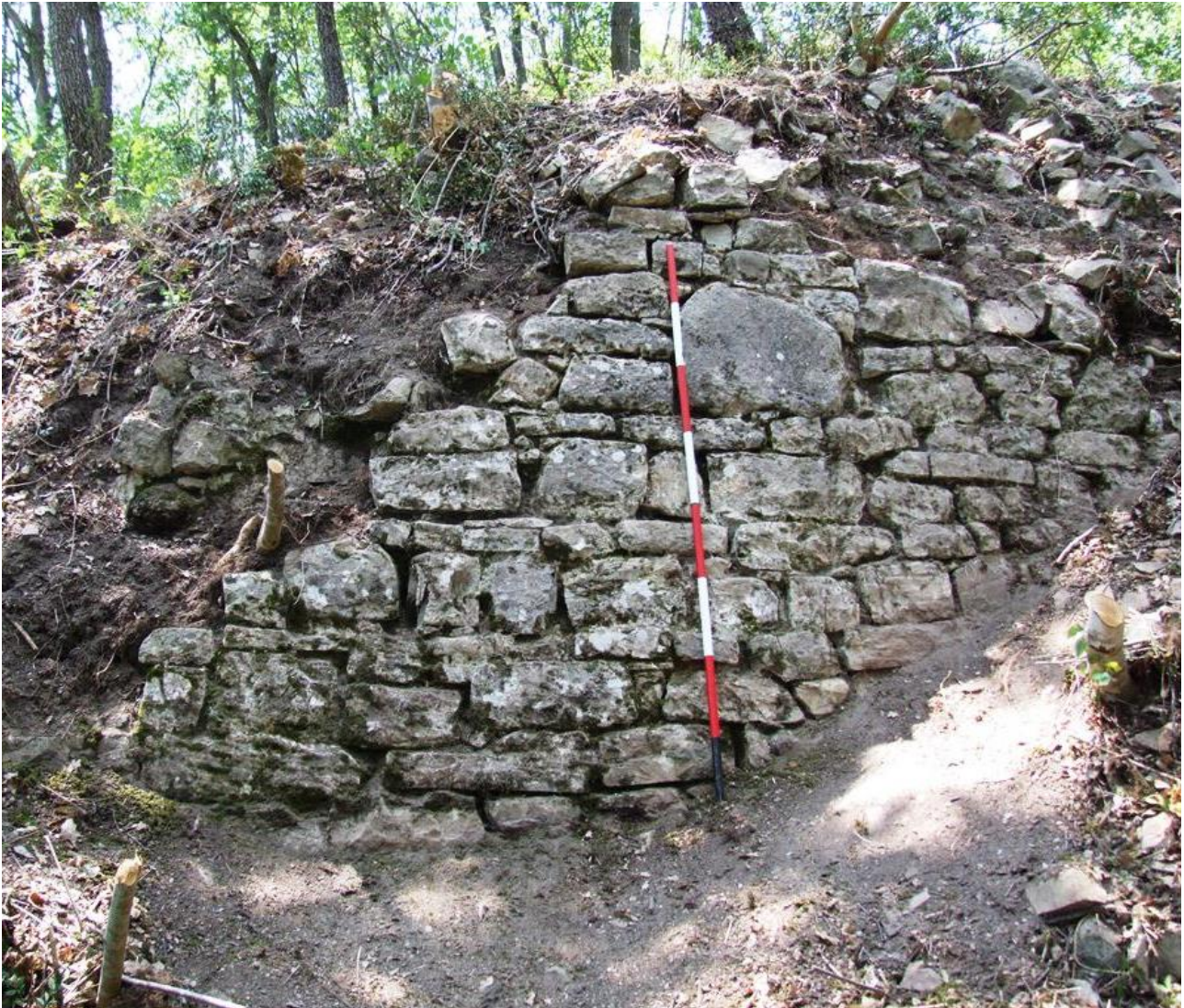
Fig. 100. Muro a scarpa (usm 1200) sul versante meridionale del terrazzamento superiore.
