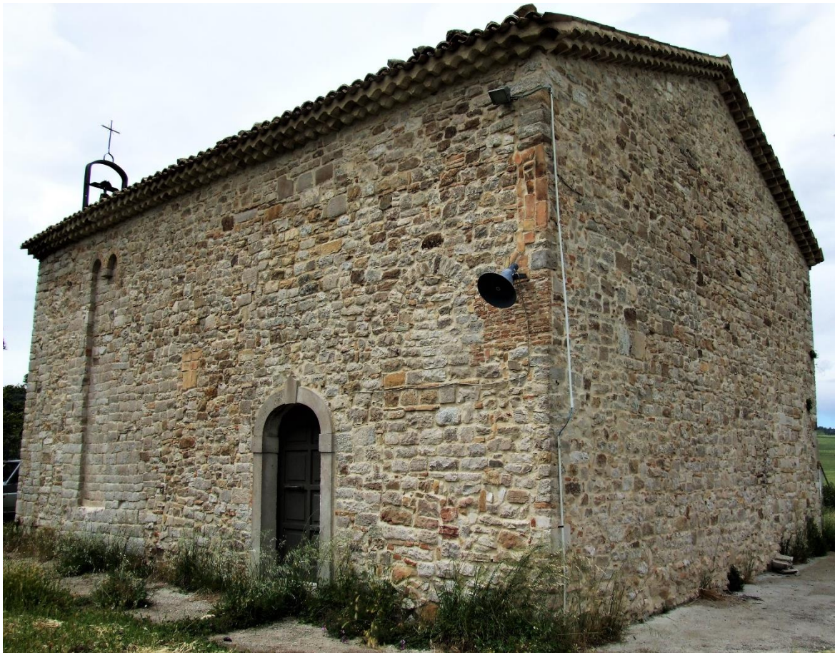
Fig. 27. Prospetto destro e posteriore della chiesa di San Pietro a Sant'Elia a Pianisi (foto. C. Ebanista).
