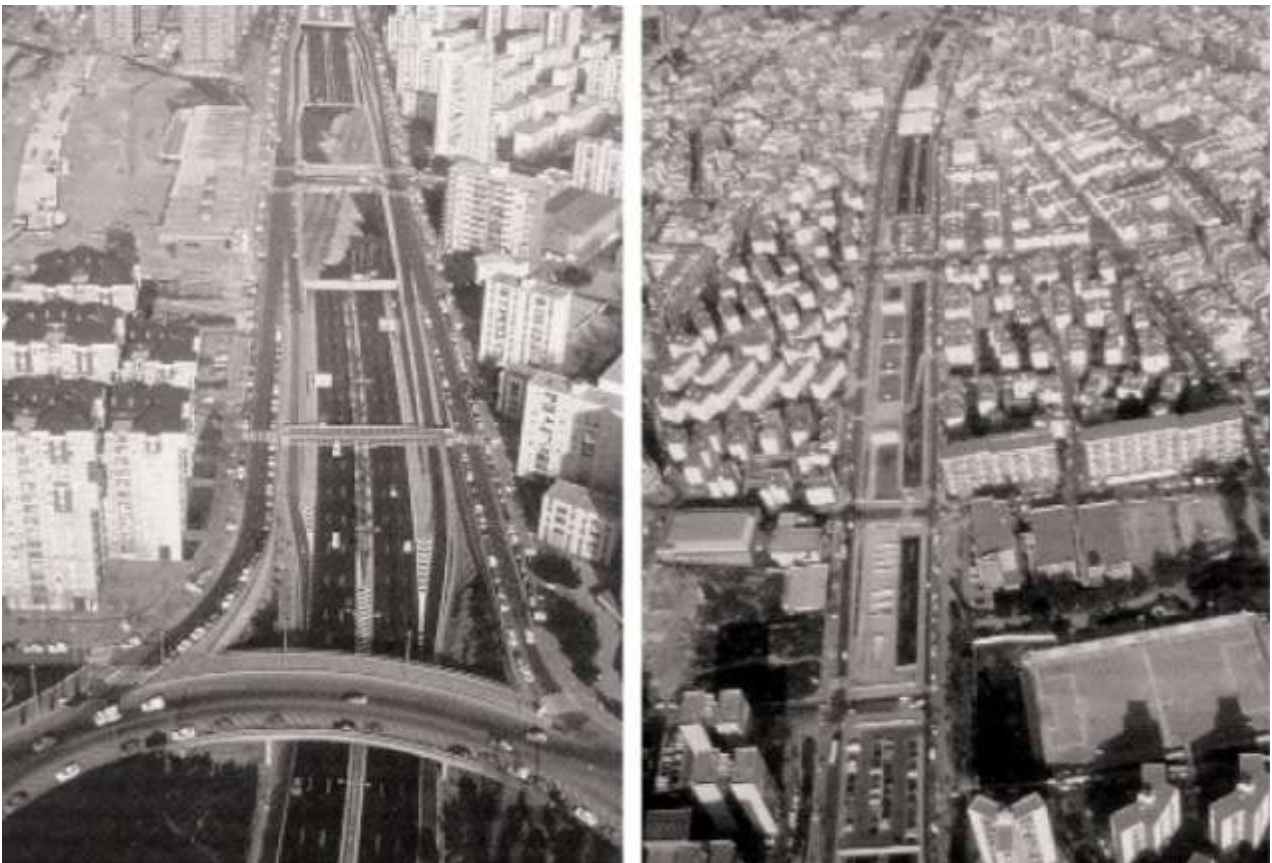
127_Barcellona: vista aerea della Ronda de Dalt [fonte: D'Onofrio P.]
