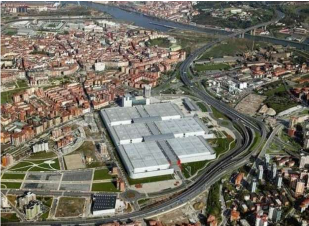
137_Bilbao: area di Barakaldo (Bilbao Exposition Centre) [fonte: Oddi C.]
