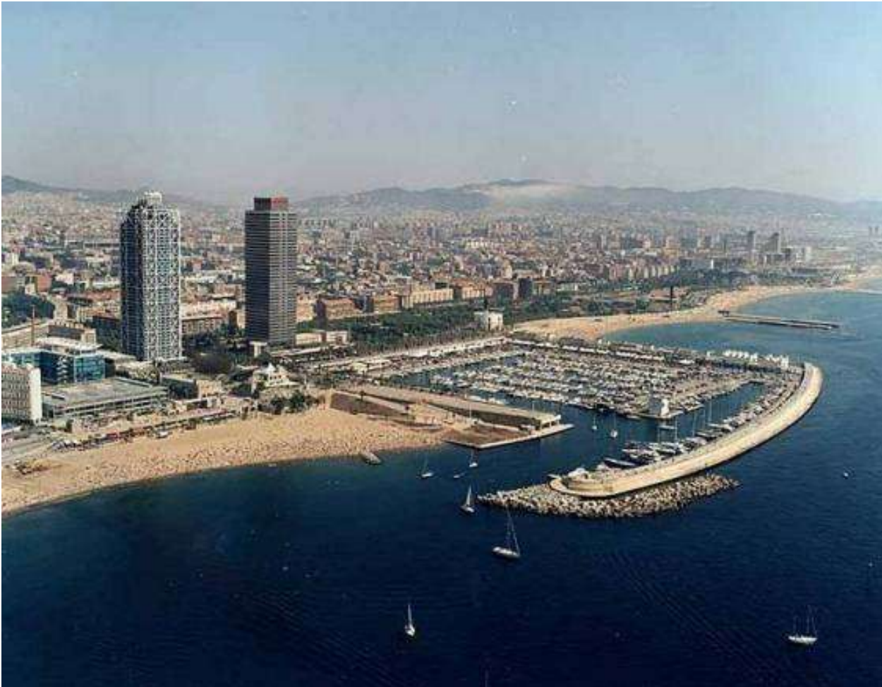
129_Barcellona: vista aerea dell'area del Porto Olimpico [fonte: www.canalmar.com]
