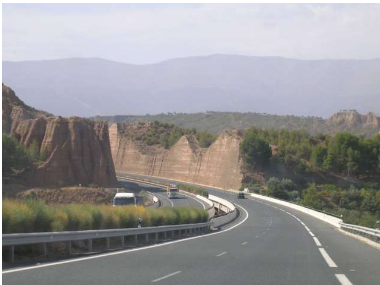
122_Autovia 381 nei pressi di Siviglia [foto: A. Sollazzo 2011]
