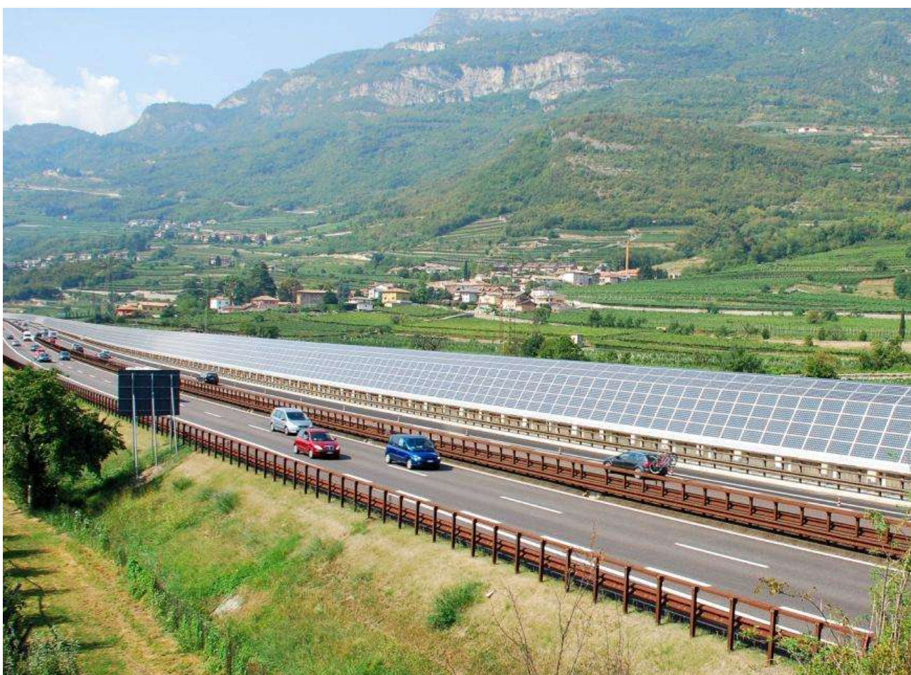
42_BARRIERA fonoassorbente in un tratto autostradale nei pressi di Trento [fonte: www.farsystem.it ]
