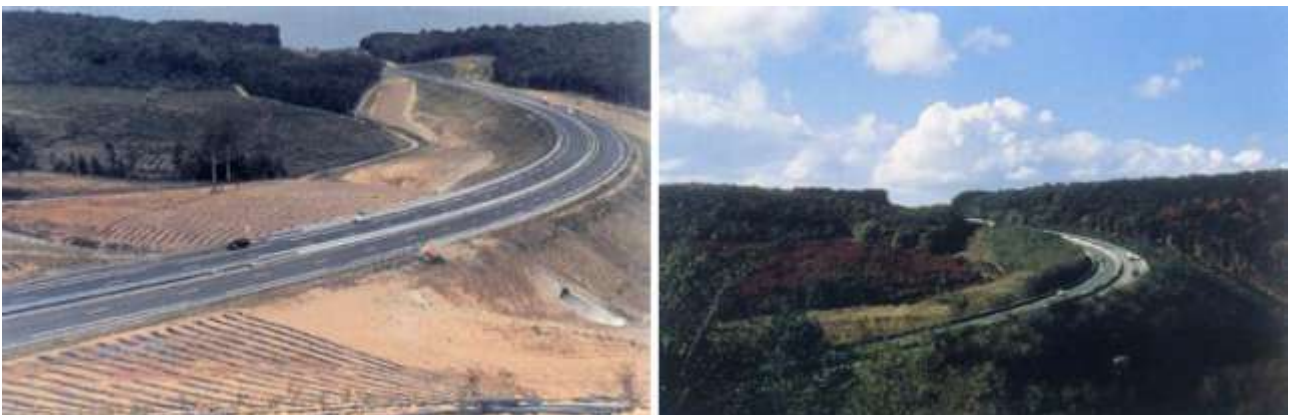
117_A89 (Angers-Tours): la sistemazione paesaggistica progettata da Lassus durante i lavori e a lavori conclusi [fonte: Ponticelli L., Micheletti C.]
