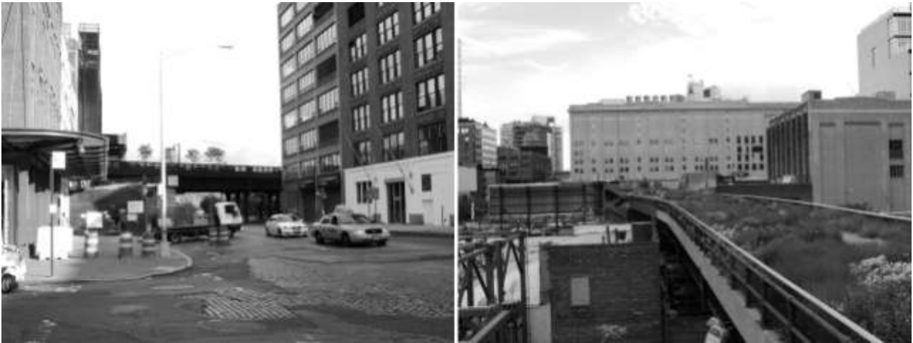
112_Spazio al di sotto della High Line. Le due immagini mettono in luce come per molti tratti il rapporto tra infrastruttura e contesto sia ancora irrisolto. Lo spazio al di sotto dell'infrastruttura si presenta ancora come un territorio limbo. [foto: A. Sollazzo 2010]
