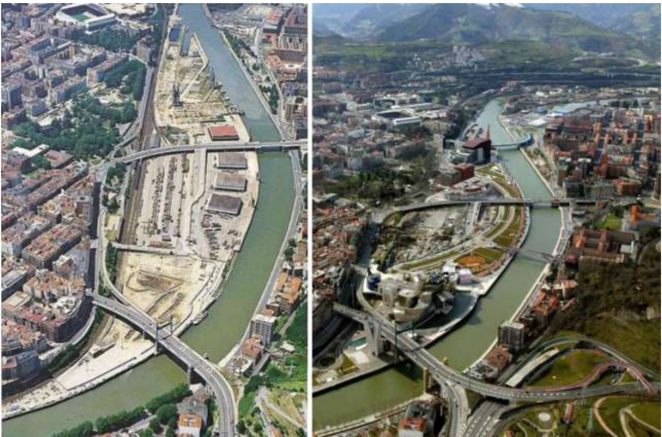
133_Bilbao: area di Abandoibarra durante la demolizione degli impianti industriali e dopo la realizzazione del Guggenheim Museum progettato da Frank O. Gehry [fonte: Oddi C.]
