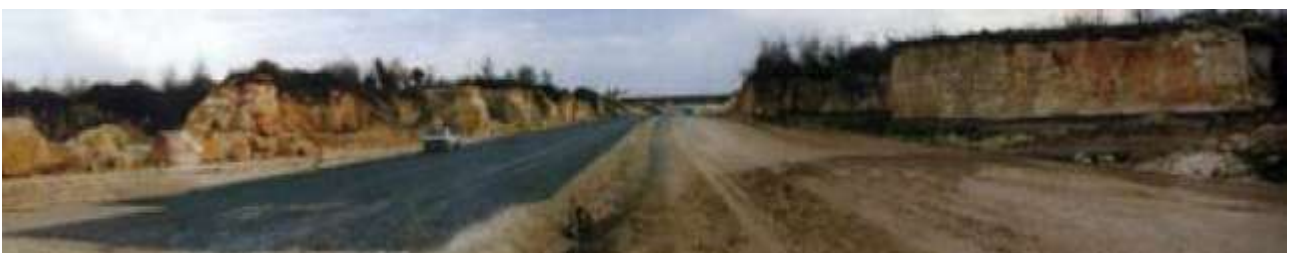
115_A837 (Saintes-Rochefort): passaggio tra le cave di Crazannes [fonte: Ponticelli L., Micheletti C.]
