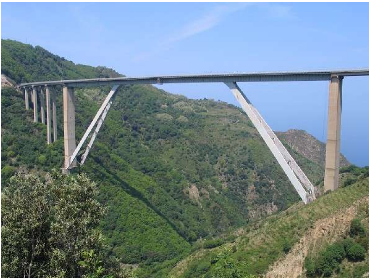
143_R. Morandi: Ponte sulla A3 (Salerno-Reggio Calabria) nei pressi di Reggio Calabria [foto: A. Sollazzo 2011]
