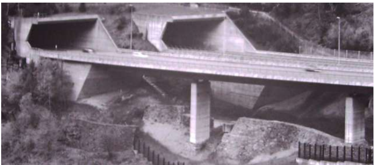
36_R. Tami, portale delle gallerie Pardorea nei pressi di Lugano [fonte: Archivio progetti IUAV]
