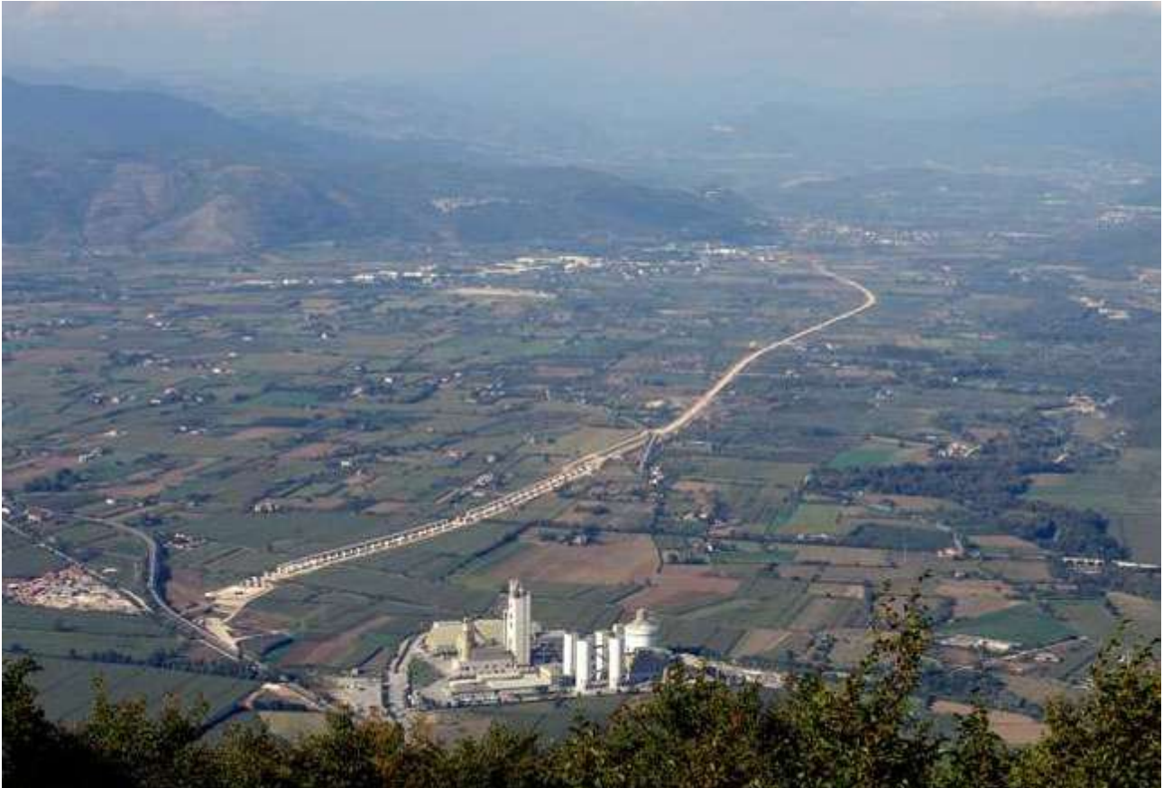
19_Il primo tratto dell'autostrada Termoli – San Vittore in costruzione nei pressi di Venafrò (IS) [foto: A. Cotugno 2008]
