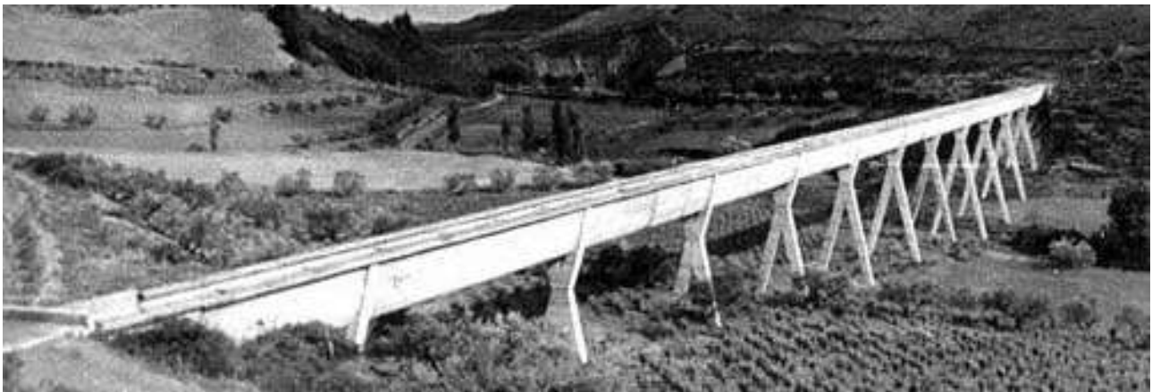
123_E. Torroja. Acueducto de Arròz [fonte: www.panoramio.com]
