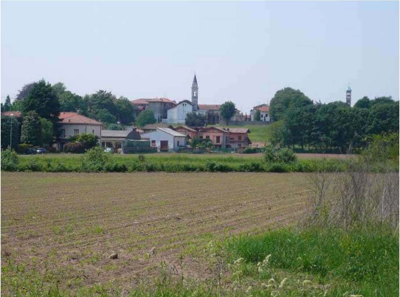
149_Pedemontana Lombarda: tratto autostradale con schema a trincea visto dal territorio [fonte: www.pedemontana.com ]
