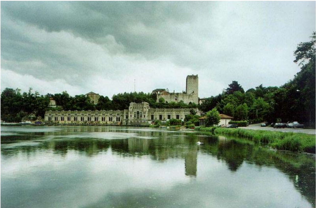
91_G. Moretti: centrale idroelettrica Taccani (Trezzo d'Adda) [fonte:www.wikipedia.it]
