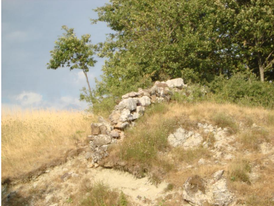
Figura 101. Muretto a secco sul tratturo Castel di Sangro – Lucera nel comune di Carovilli.
