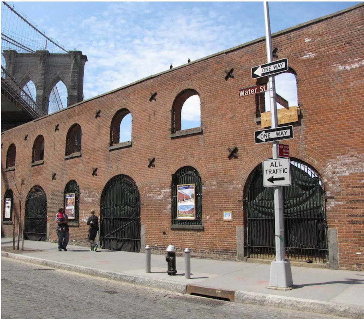
Figura 45. Brooklyn Bridge Park, Tobacco Warehouse, foto N. Quercio, settembre 2014
