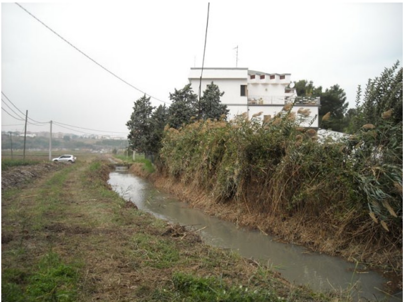
Figura 107. Abitazione sul canale di bonifica in c.da Marinelle (fonte Consorzio di bonifica Trigno e Biferno)
