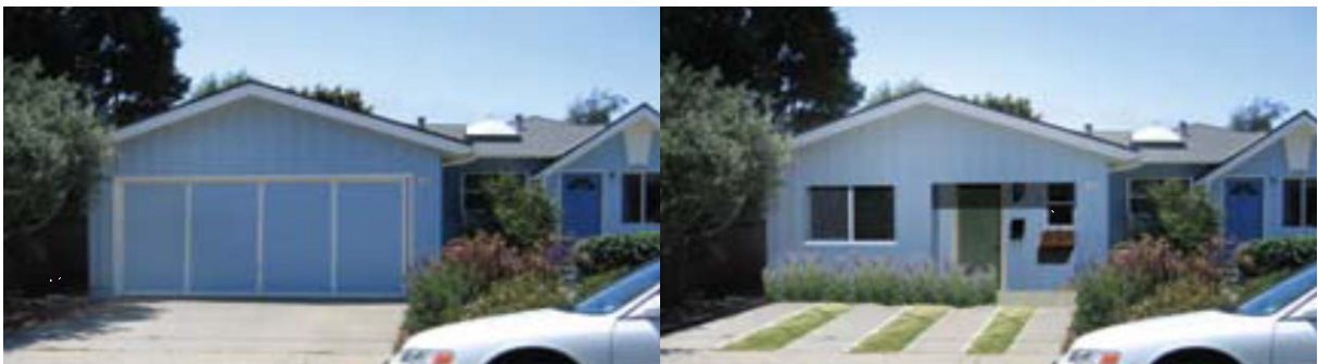
Figura 24 Cambiamento di destinazione d'uso da garage (foto a sinistra) a Accessory Dwelling Unit (foto a destra) da http://coastalsmartgrowth.noaa.gov
