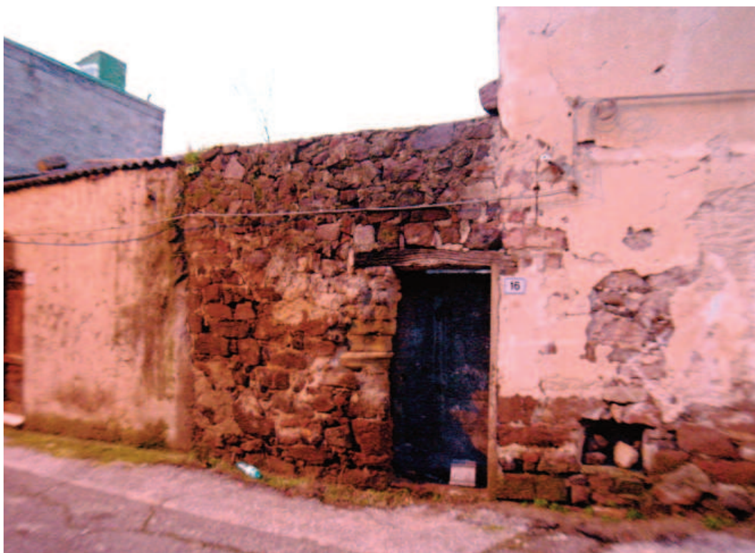
Ottana. Lo scatto in alto mostra quanto rimane di un edificio a tipologia elementare inglobato e fagocitato (ne resta la parete ovest perimetrale esterna) dalla nuova costruzione, talmente vasta da non essere definitivamente neppure compiuta.
