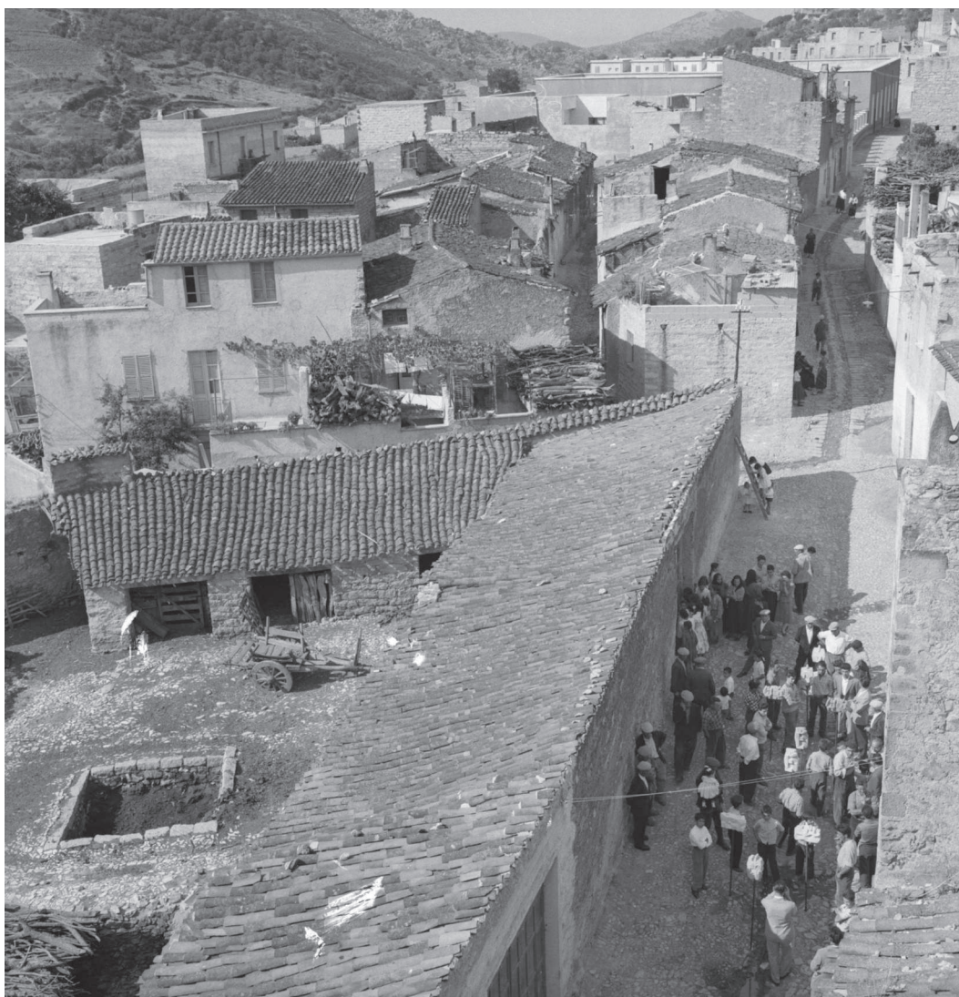
Orani. marzo 1958, rione "Su Rosariu", foto di Carlo Bavagnoli. Lo scatto, eseguito dal campanile della chiesa, restituisce una nitida immagine di una vasta corte domestica; in essa è ben visibile la vasca per lo spegnimento del grassello di calce. La ripresa (chiesta da Life ) era finalizzata a documentare la mostra di sculture lungo la via, eseguite da Costantino Nivola.
