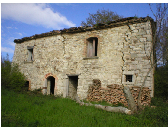
FIG. 6.1 – Costruzione in pietra – Baranello (CB)
