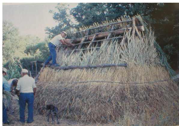
FIG. 1.27 Catropignano (CB):Pagliara in costruzione.
