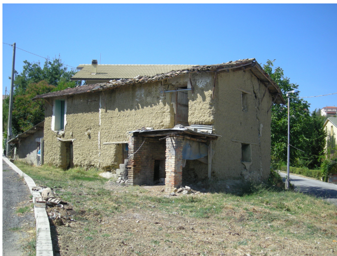
FIG. 6.2 – Edificio in terra battuta, Casalincontro (CH)
