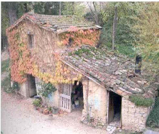
FIG. 2.6 - Casa in terra nelle Marche
