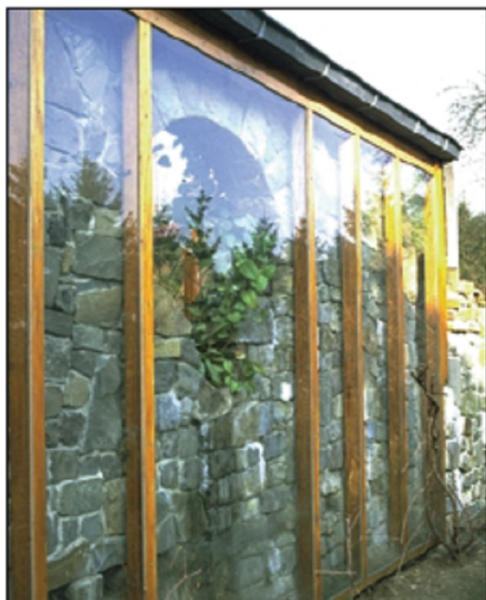
FIG. 12.19 – Applicazione del muro di Trombe.
