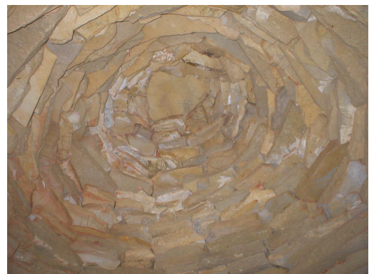
FIG. 2.9 - Trullo molisano, interno della tholos
