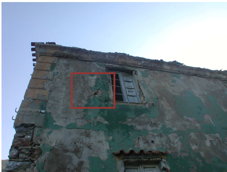
Figura 50: L'immobile di Buggerru: in rosso una delle zone di discontinuità della scatola muraria (Fonte: Progetto Posadas)
