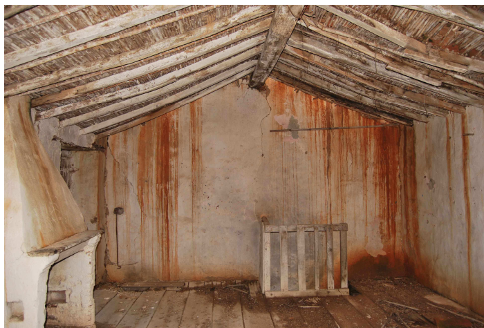
Figura 61: Jerzu- struttura semplice trave di colmo senza arcarecci (Fonte: Progetto Posadas)
