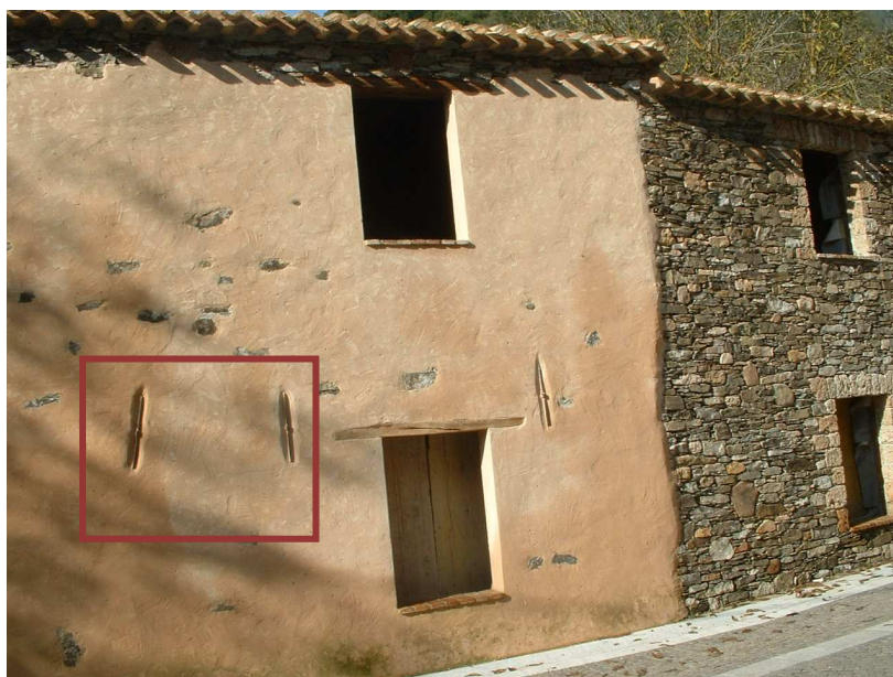
Figura 52: Abitazione a Sadali: inserimento dei tiranti (Fonte: Progetto Posadas)
