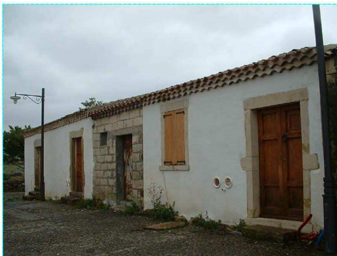
Vista prospetto principale mappale e (foto n°7)
