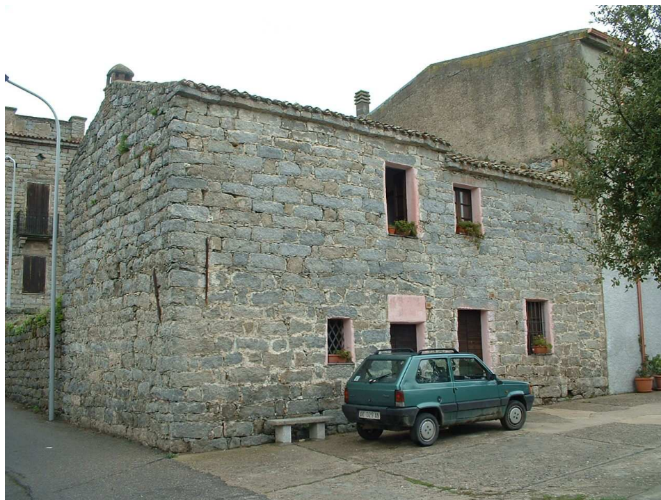
Figura 44: Casa ad Osidda (Fonte: Progetto Posadas)
