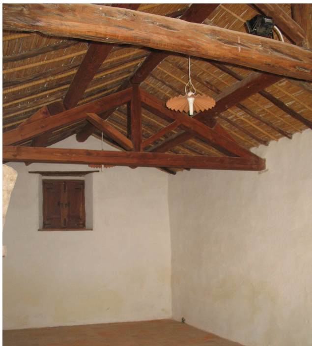
Figura 63: Tratalias- Capriata sormontata dalla trave di colmo, arcarecci e travicelli (Fonte: Progetto Posadas)
