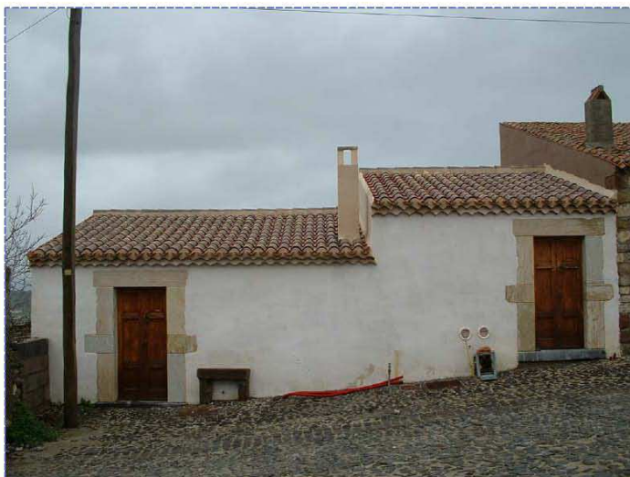
Vista prospetto principale mappale e (foto n°3)
