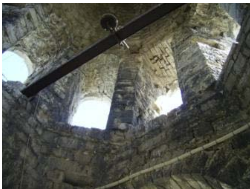
Figura 13: Ripabottoni, Chiesa di S.M. Assunta: Cella campanaria con ampie aperture
