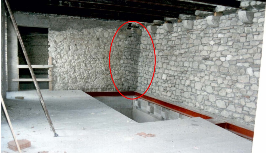
Figura 69: Palazzo Japoce in Campobasso durante gli interventi: le due tipologie murarie. La breccia aperta (segnata nell'ovale) evidenzia la mancanza di ammassamento (foto: Soprintendenza BAP Molise)
