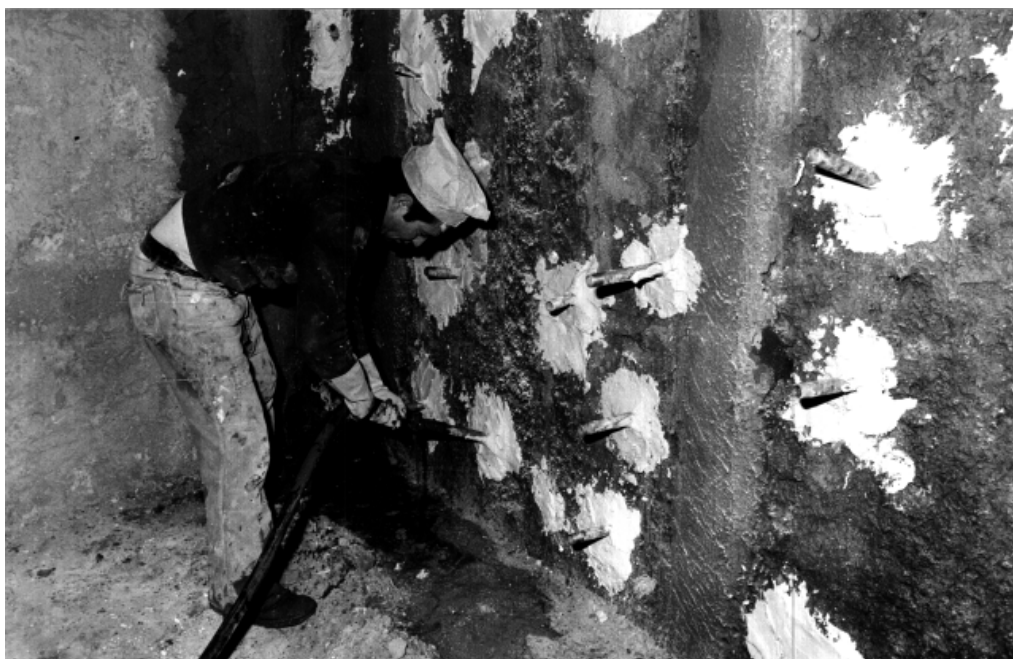
Figura 78: Palazzo Mazzarotta in Campobasso: Esecuzione delle iniezioni. (foto: Soprintendenza BAP Molise)
