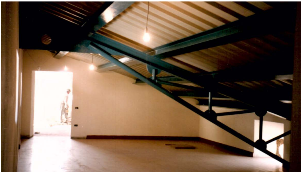
Figura 72: Palazzo Japoce in Campobasso: La copertura in acciaio e lamiera. (foto: Impresa Macchiarola, Campobasso)
