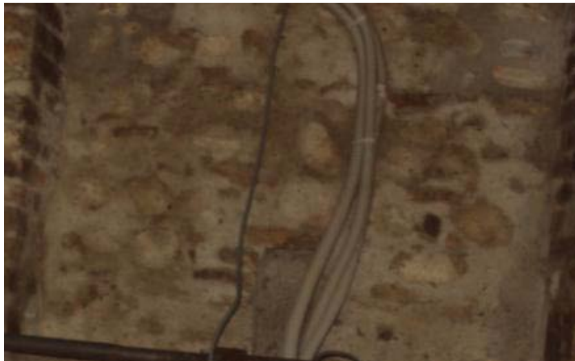
Figura 41: Campanile della Chiesa di S. Alfonso dei Liguori in Colletorto: Particolare della muratura
