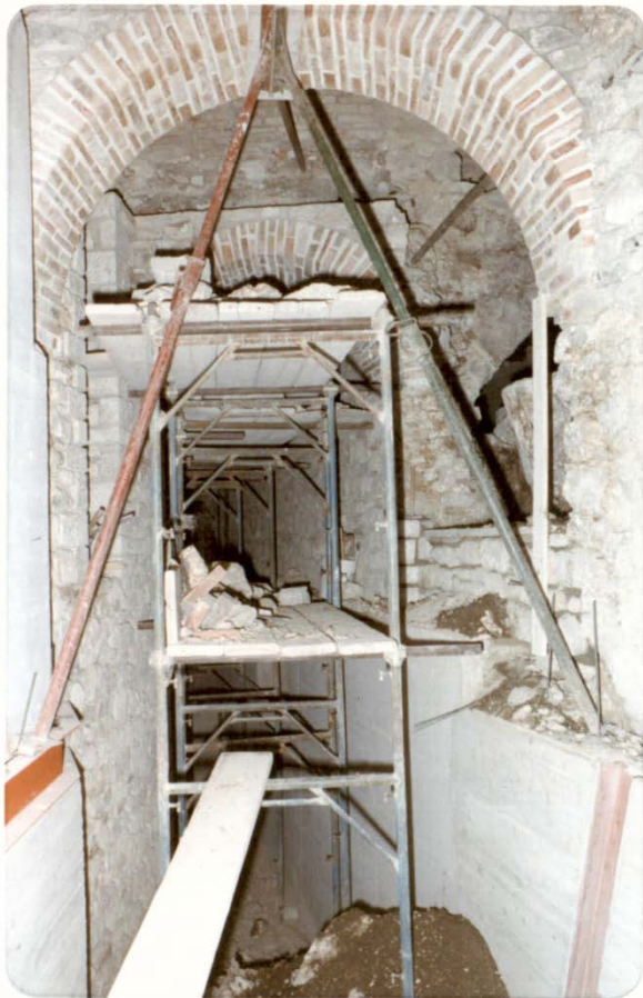
Figura 70: Palazzo Japoce in Campobasso: a sinistra rifacimento degli archi, a destra rifacimento delle piattabande ed incamiciatura delle pareti a pianoterra. (foto: Soprintendenza BAP Molise)
