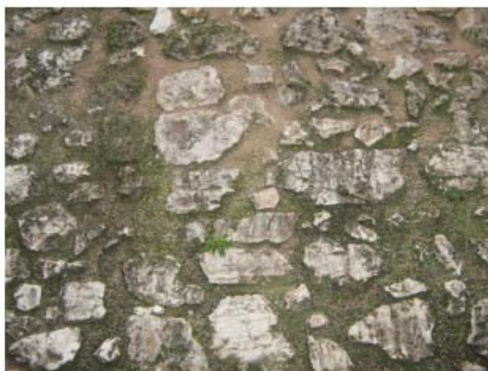
Figura 63: Castello Pandone in Venafro: particolare della muratura
