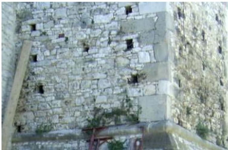
Figura 44: Campanile della Chiesa di S. Maria Assunta in Provvidenti: Particolare della muratura
