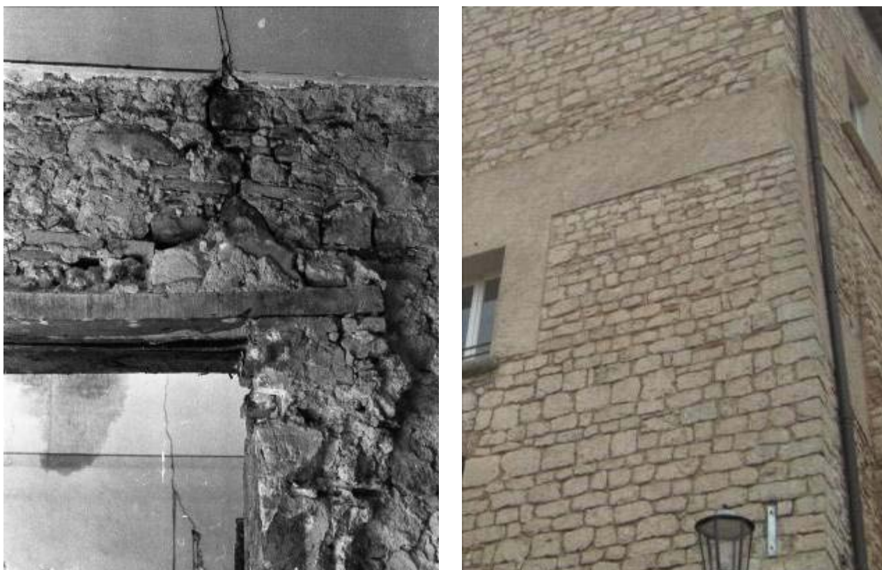
Figura 75: Palazzo Mazzarotta: le due tipologie murarie, a sinistra (foto: Soprintendenza BAP Molise) quella interna ed a destra quella esterna
