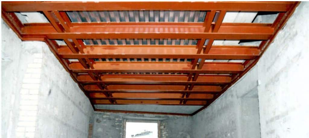
Figura 71: Palazzo Japoce in Campobasso: Uno dei solai nuovi, in acciaio e lamiera grecata. (foto: Soprintendenza BAP Molise)
