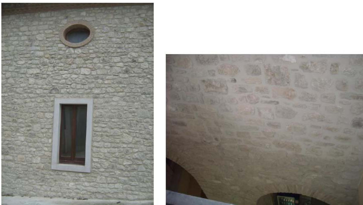
Figura 68: Palazzo Japoce in Campobasso: Le due tipologie murarie, a sinistra la tipologia esterna ed a destra la tipologia interna
