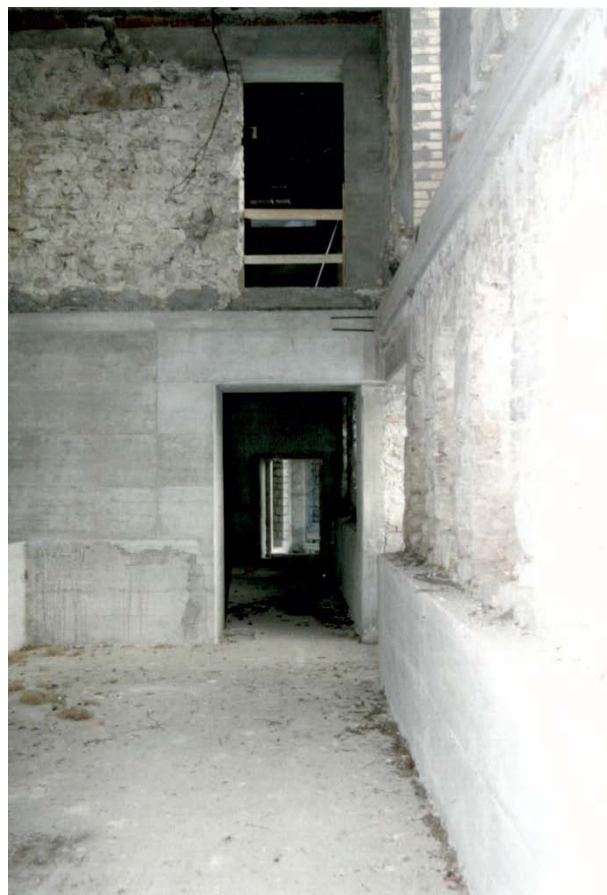
Figura 70: Palazzo Japoce in Campobasso: a sinistra rifacimento degli archi, a destra rifacimento delle piattabande ed incamiciatura delle pareti a pianoterra. (foto: Soprintendenza BAP Molise)
