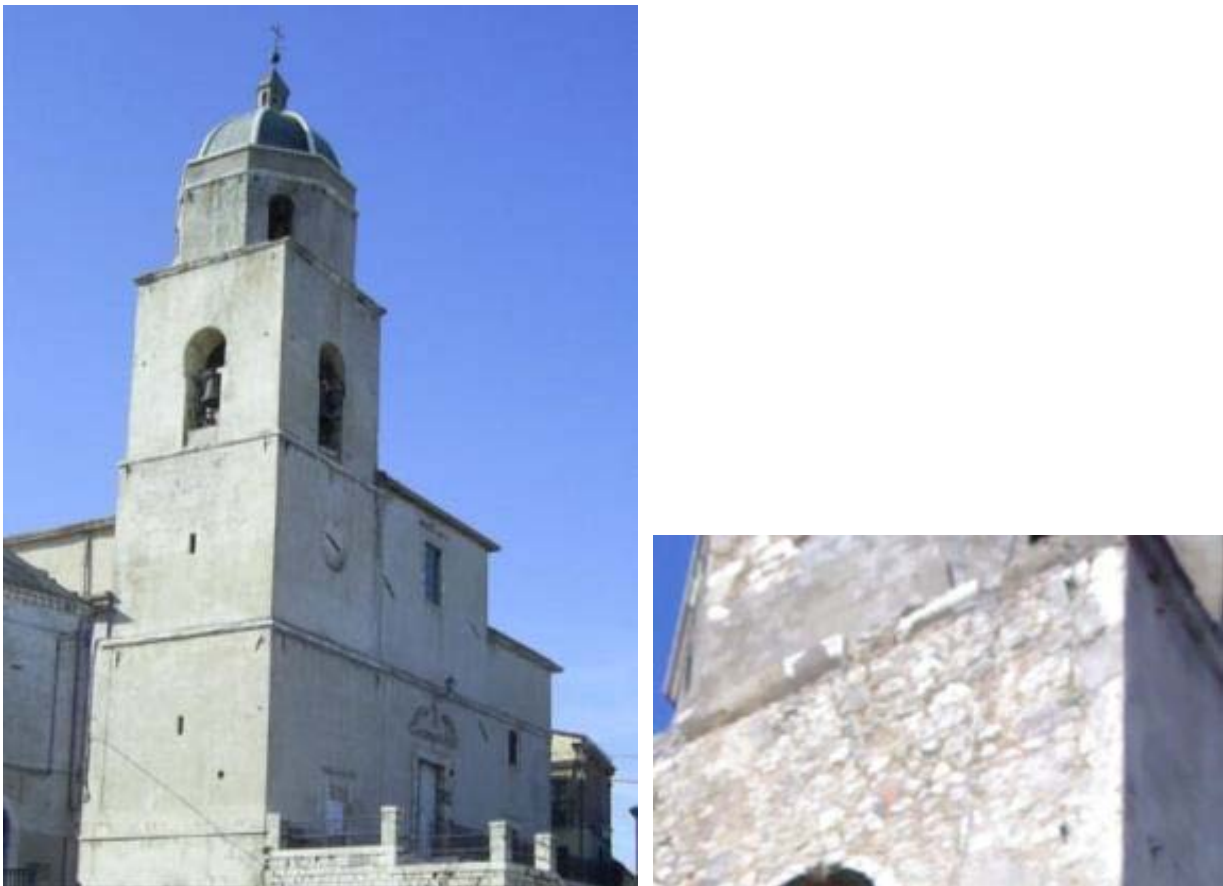
Figura 19: Campanile della Chiesa di S. Maria delle Rose in Montorio nei Frentani e a destra particolare della muratura
