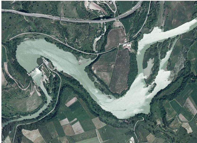
Fig. 2.4 – Traversa di Persano (Ortofoto 1998). È possibile notare dalla foto aerea la presenza di insabbiamento all'interno della struttura
