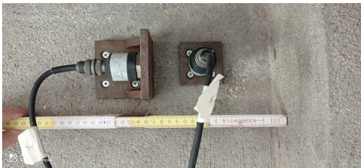
Figura 2.2. Piastre e sensori ancorati sui muri.
