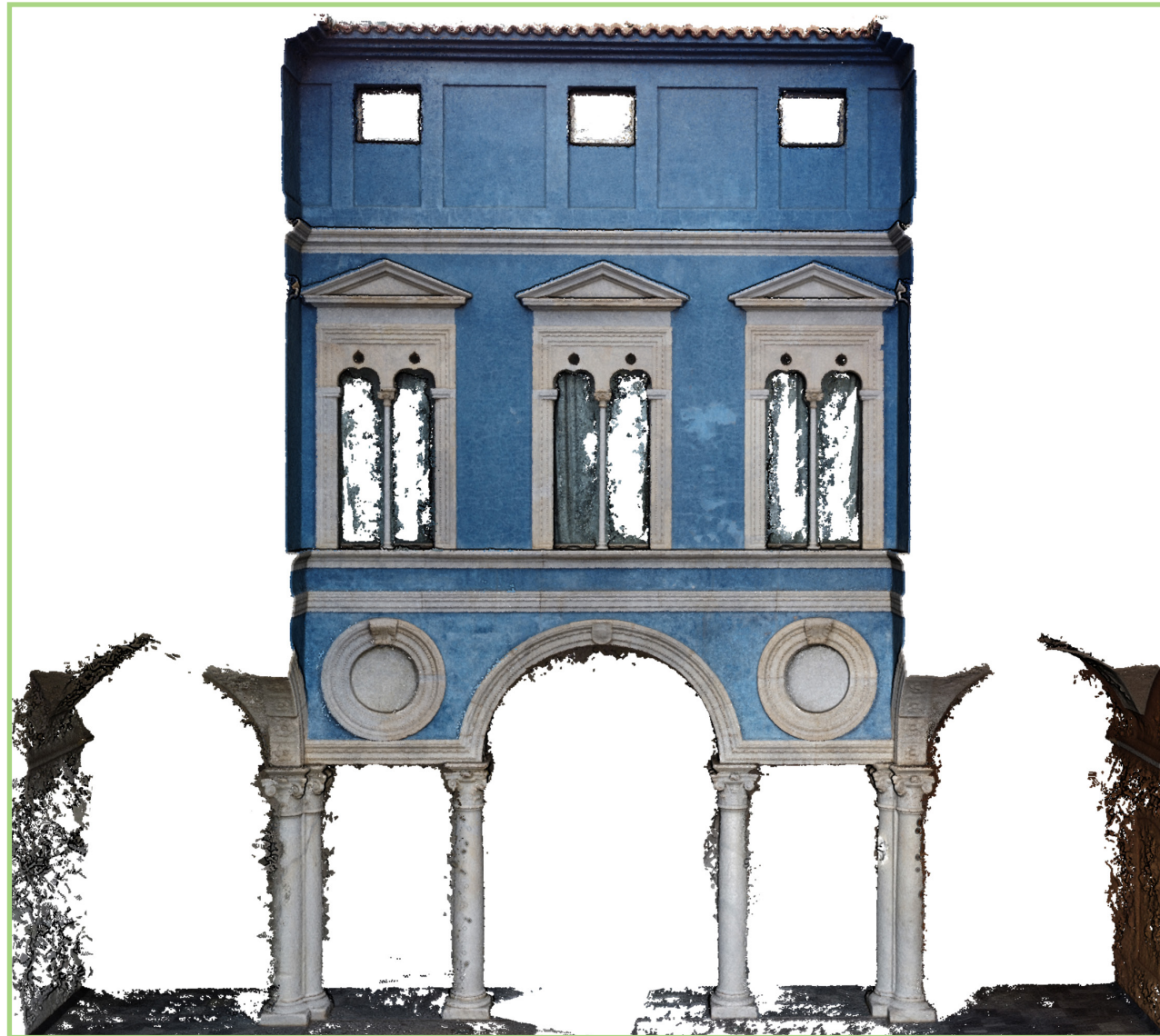
Fig. 4.4 La nuvola fotogrammetrica della facciata sud-est (elaborazione dell'autore).
