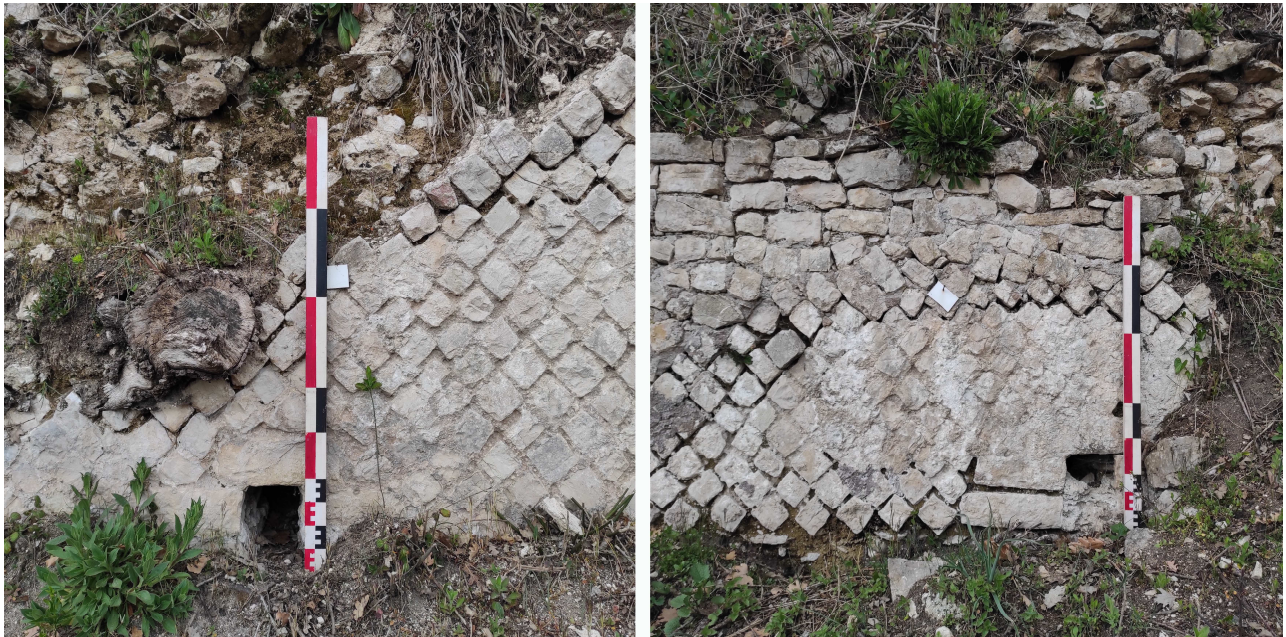
Figura 64 - Tratto di muratura localizzato nella porzione O del sito archeologico in prossimità del fabbricato II dove è stato censito il campione n. 1.
