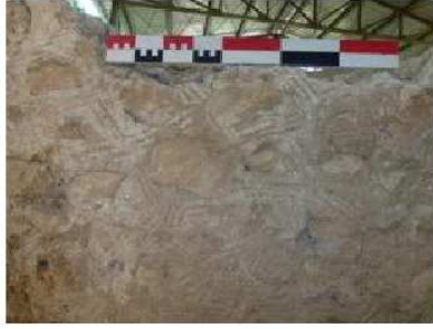
MR-0567-3.jpg - Campione (fotografia / rilievo) : Particolare dei giunti lisciati con tracce oblique
