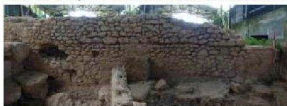
MR-0568-3.jpg - Campione (fotografia / rilievo) : Facciata esterna che affaccia sulla viabilità.
