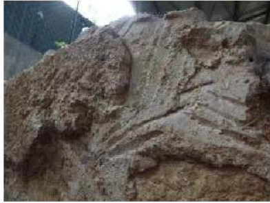
MR-0567-4.jpg - Vista di dettaglio : Particolare lisciatura giunti con tracce oblique.
