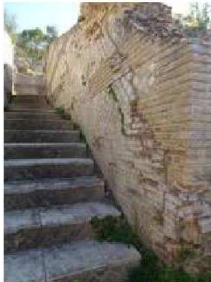
PO-0049-3.jpg - Vista generale
