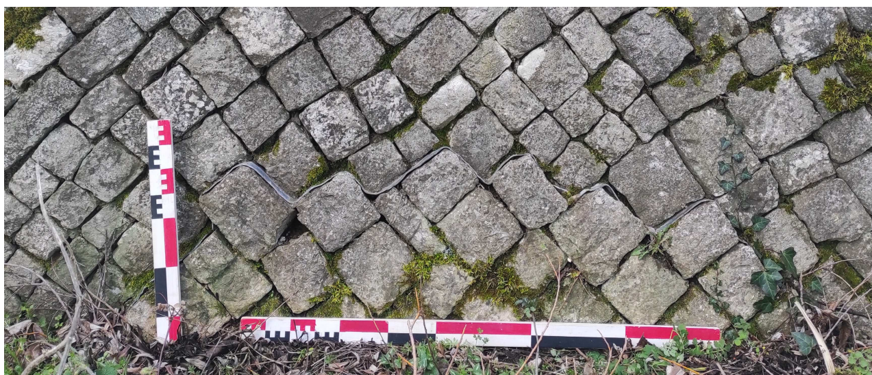
Figura 52 - Guaina in metallo utilizzata per i restauri del primo biennio del 2000.
