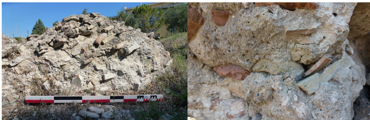
Figura 35 - Particolari del sacco di riempimento della muratura in cui si nota la presenza di frammenti di coppi, laterizi e ceramica. I blocchi riportate in queste immagini provengono dal crollo delle volte nella porzione N/O del monumento.
