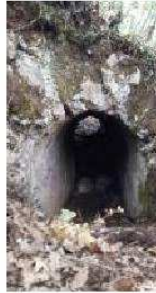
AR-0048-5.jpg - Vista di dettaglio Foto A. Di Meo
