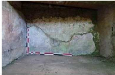
MR-0567-5.jpg - Campione (fotografia / rilievo) : Parete interna intonacata
