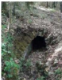
AR-0048-2.jpg - Vista di dettaglio Foto A. Di Meo
