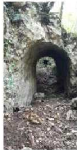
AR-0048-6.jpg - Vista di dettaglio Foto A. Di Meo
