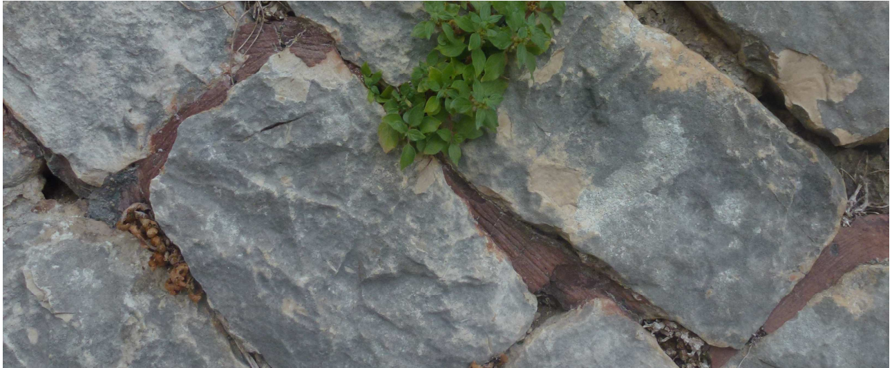
Figura 43 - Particolare di stacco delle murature fra parte originale e moderna tramite l'ausilio di cemento colorato.
