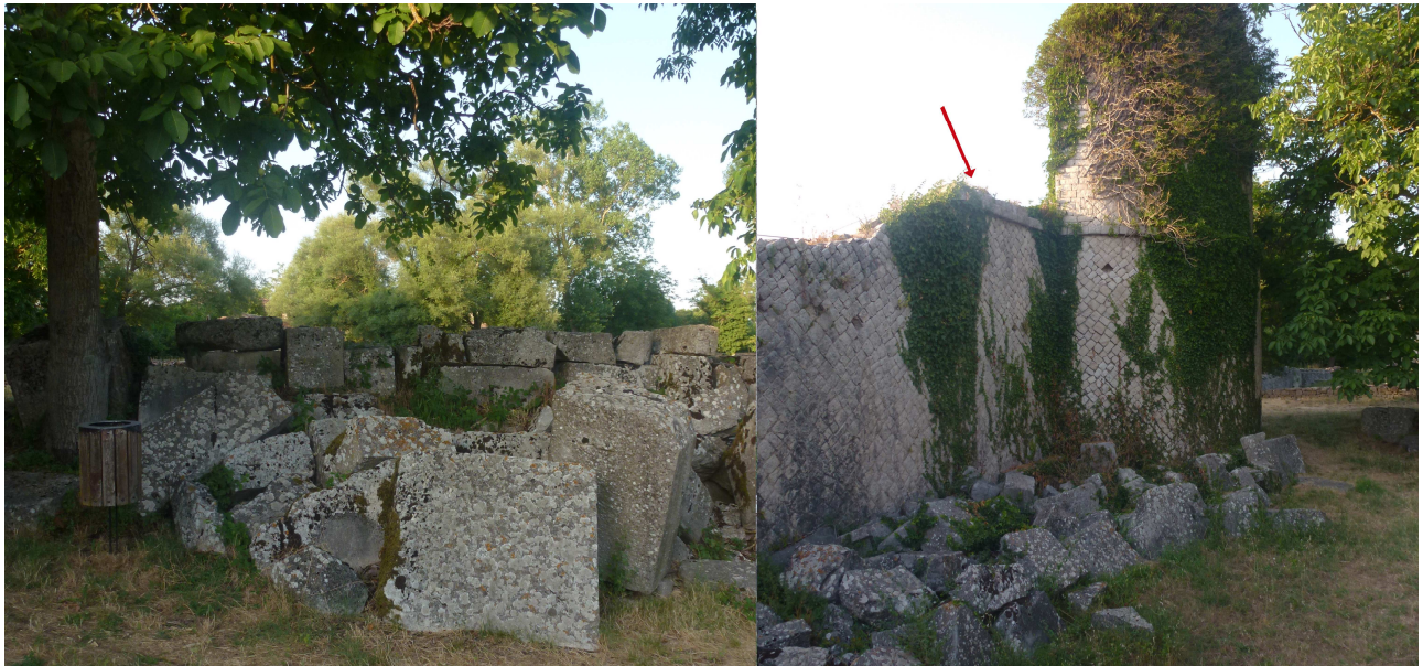
Figura 42 - Immagine relativa ai blocchi in pietra, riferibili ad una possibile cornice marcapiano della cinta muraria, accumulati in due diversi punti lungo il circuito murario. Nell'immagine a destra che ritrae la torre in prossimità del teatro ricostruita negli anni '50, per un'altezza di più di undici metri, è possibile vedere come alcuni blocchi (indicati con la freccia rossa) siano stati riposizionati sulla cresta del circuito murario.
