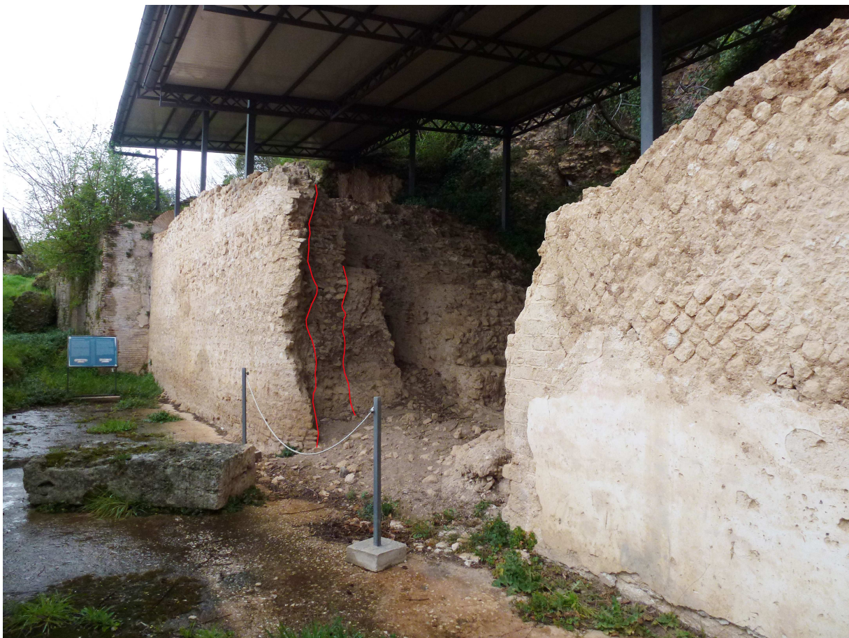
Figura 25 - Interventi nell'area O del teatro. In rosso sono evidenziati tre interventi costruttivi sovrapposti di cui in paramento con codice ACoR MR-0565 ne costituisce l'ultimo.
