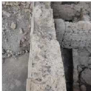
MR-0567-9.jpg - Vista di dettaglio : particolare della sezione della muratura
