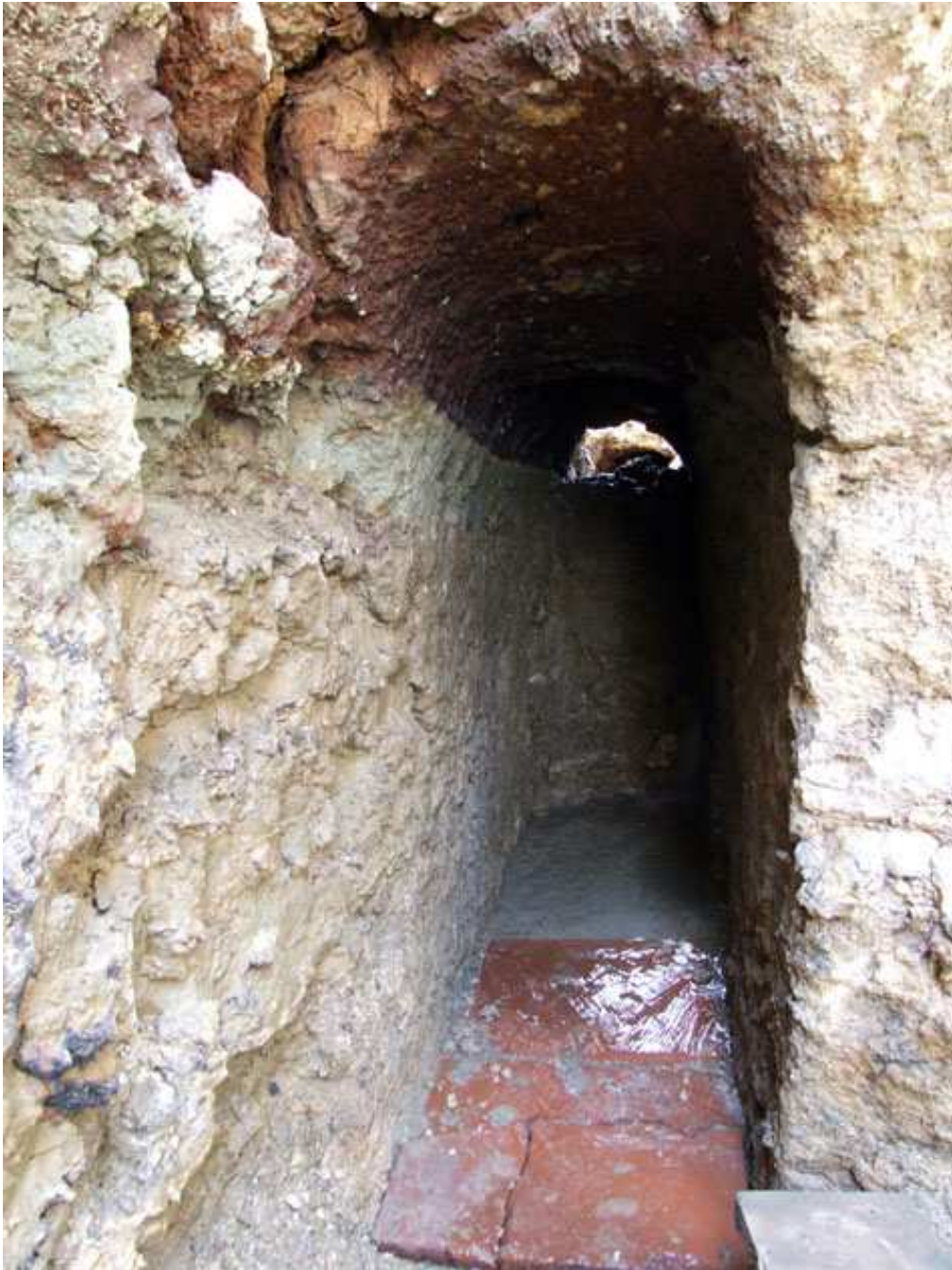
Figura 29 - Particolare di condotta scavata direttamente nella roccia con pavimentazione in laterizio (da VALENTE 2008).
