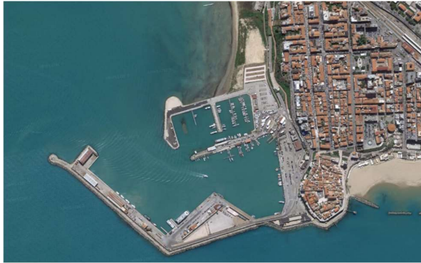
Figura 83 – Il porto di Termoli visto dall'alto. Fonte: https://earth.google.com/
