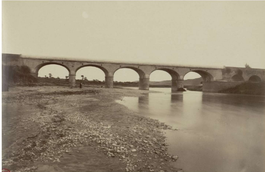
Figura 3 – Achille Mauri, Ponte sul fiume Biferno al km. 9.500, anno 1883. Fonte: Società Italiana, Strade Ferrate Meridionali, Linea Termoli-Campobasso.
